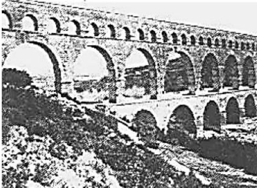
Gambar 2.2 Jembatan Aqua Duct Pont Du Gard pada Periode Romawi Kuno (Sumber : Bambang Supriyadi dan Agus Muntohar, 2007)
