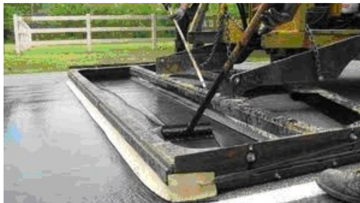
Gambar 1. Pembuatan Jalan Aspal
