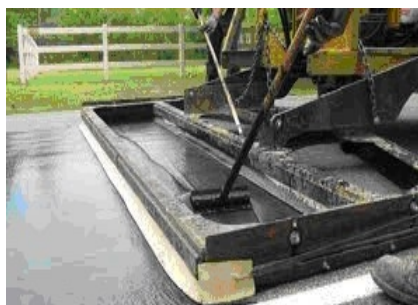
Gambar 1. Pembuatan Jalan Aspal
