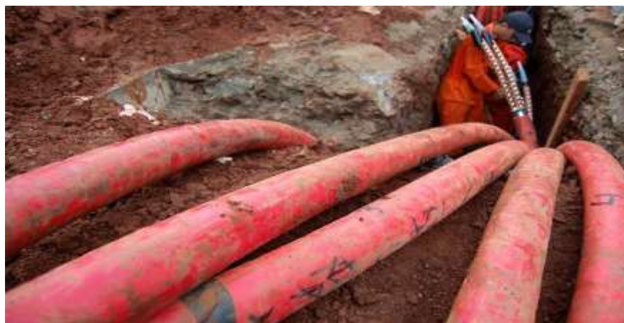
Gambar 2.13 Saluran Kabel Tegangan Tinggi
