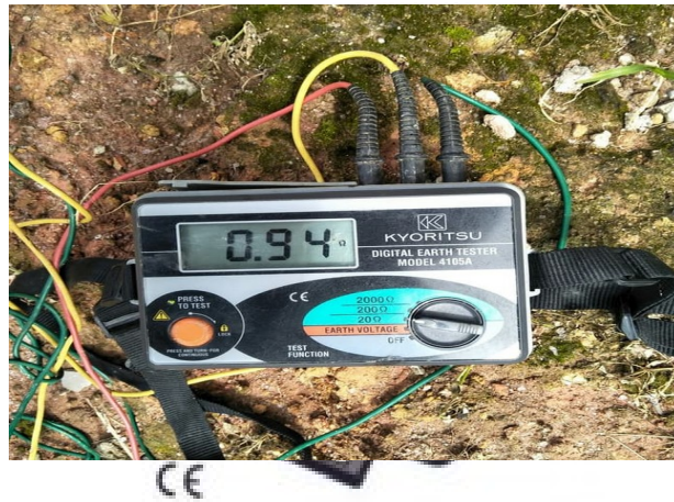
Gambar 2.20 Alat Uji Tahanan Pentanahan
