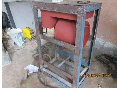
Pemasangan Primary Chamber dan penampung Absorben
