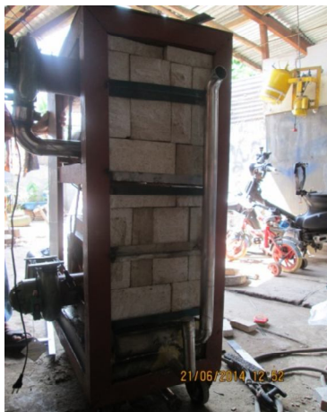
Pemasangan Batu Tahan Api
