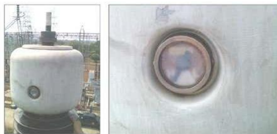
Gambar 2.8 Indikator level minyak bushing
