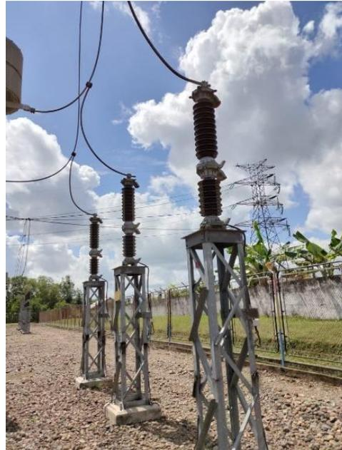
Gambar 2.8 *Lightning Arrester (LA)*
