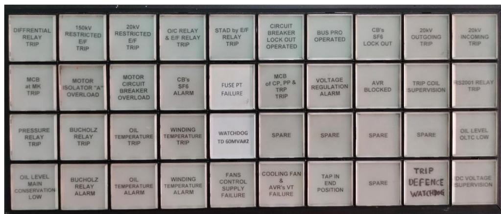
Gambar 2.13 Alarm Annunciator pada Panel Kontrol
