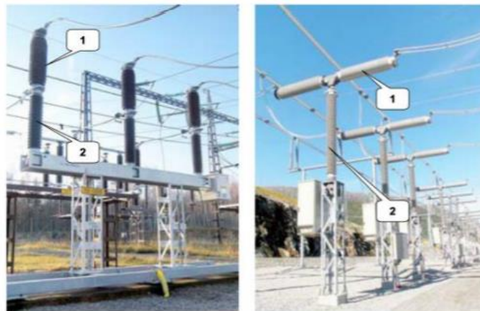
Gambar 2.15 Isolator Pada Interrupting Chamber dan Support
