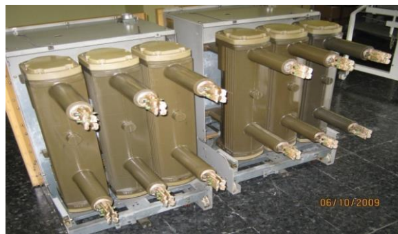
Gambar 2.10 PMT 20 kV Media Pemadam Busur Api SF6
