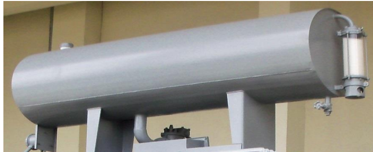
Gambar 2.14 Tangki Konvensator
