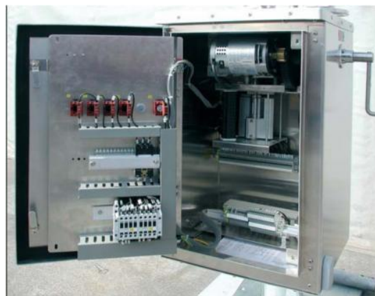
Gambar 2.7 Mekanik penggerak PMS dengan motor
