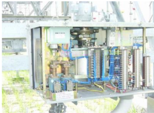
Gambar 2.8 Mekanik penggerak PMS dengan Pneumatik
