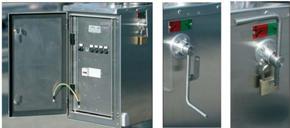
Gambar 2.6 Mekanik penggerak PMS manual
