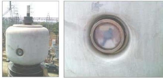
Gambar 2.8 Indikator level minyak bushing
