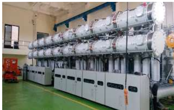
Gambar 2.6 Gardu pasang dalam atau GIS
