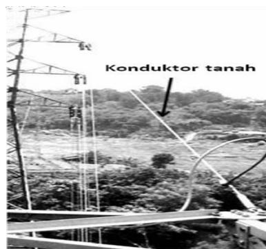
Gambar 2.37 Konduktor tanah
