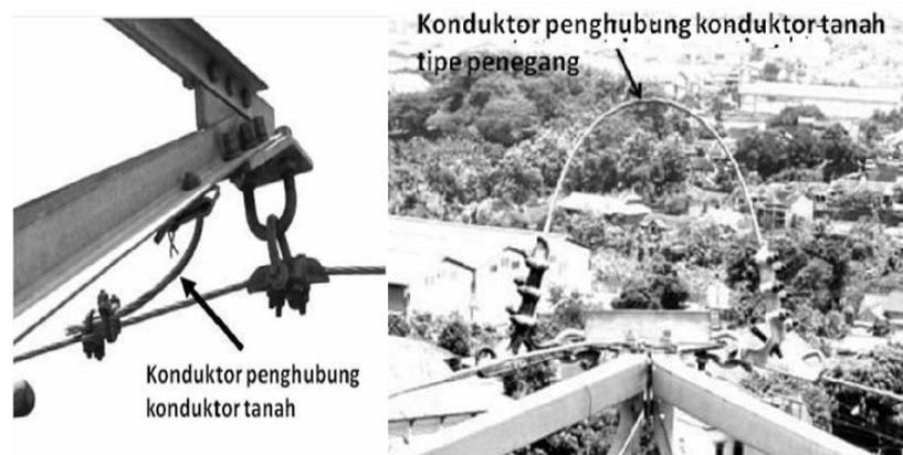
Gambar 2.38 Konduktor penghubung konduktor tanah
