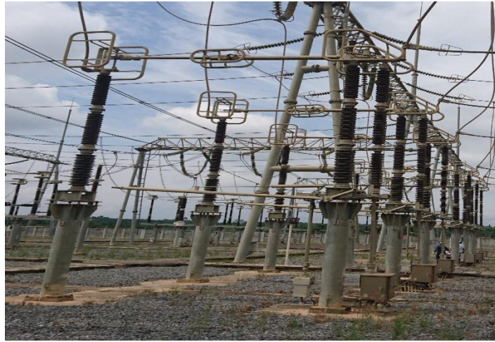
Gambar 2.9. Pemisah pada switchyard 275kV PLTU Sumsel V
