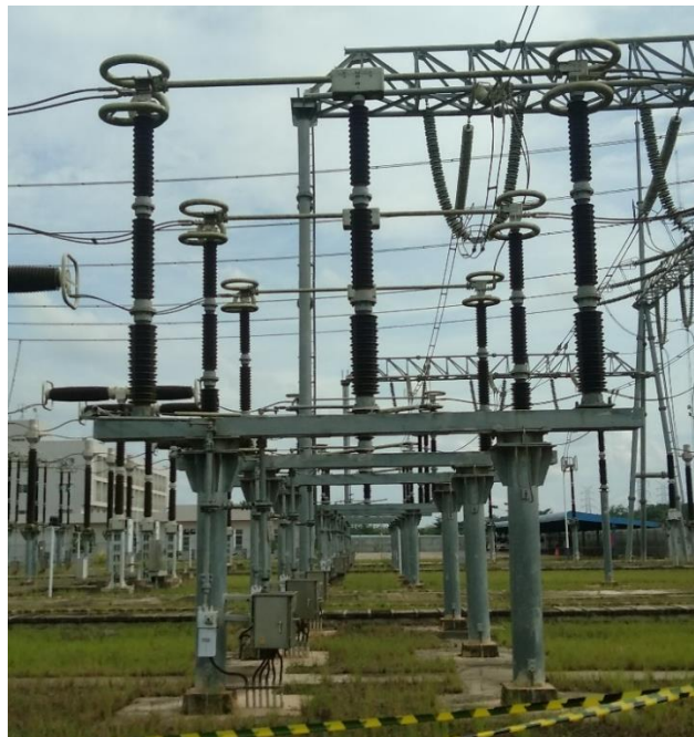
Gambar 2.10. Earthing Switch pada switchyard 275kV di PLTU Sumsel V
