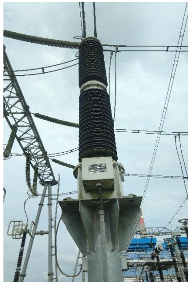
Gambar 2.11. Transformator tegangan pada switchyard 275kV di PLTU Sumsel V
