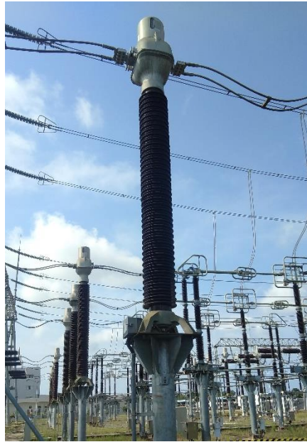
Gambar 2.12. Transformator arus pada switchyard 275kV di PLTU Sumsel V.
