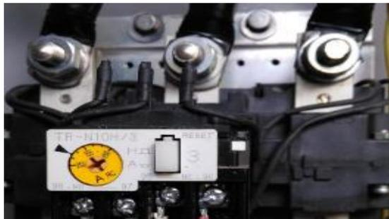
**Gambar 2.8** TOR pada motor FDF
