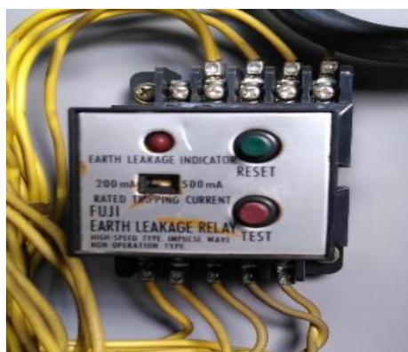
**Gambar 2.9** ELR pada motor FDF
