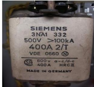
**Gambar 2.7** *Fuse* pada motor FDF
